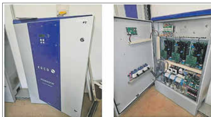
Abb. 3 und 4 – Wechselrichter KACO Powador 33.000 Xi-XL-IT-Park
