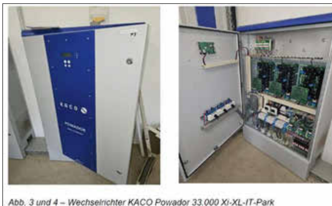
Abb. 3 und 4 – Wechselrichter KACO Powador 33.000 Xi-XL-IT-Park
