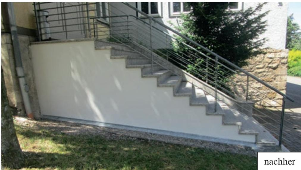
Der Putz an der Außenwand zur Treppenanlage zum Saal Haarhausen war durch einen Feuchteintrag marode. Daher wurde die Firma Kühnast mit der Sanierung dieser Außenwand und Herstellung einer sauberen Oberflächengestaltung beauftragt. Da auch die Silikonfugen in den Treppenstufen verschließen waren, wurden diese durch die Firma Rahnfeld mittels Hochleistungsdichtstoff erneuert.
