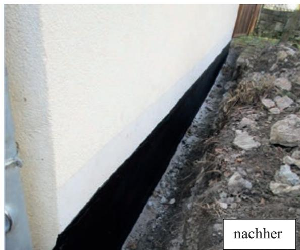
Der Feuchtigkeitsschaden am Feuerwehrgerätehaus im OT Bechstedt-Wagd wurde durch Trockenlegung und Abdichtungsmaßnahmen behoben.
