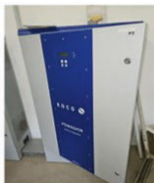
Abb. 3 und 4 – Wechselrichter KACO Powador 33.000 Xi-XL-IT-Park
