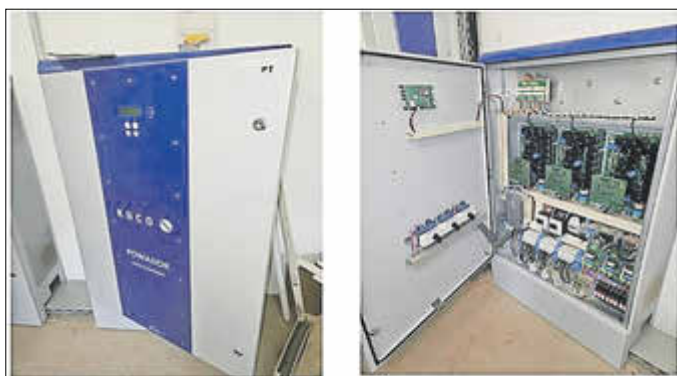
Abb. 3 und 4 – Wechselrichter KACO Powador 33.000 Xi-XL-IT-Park
